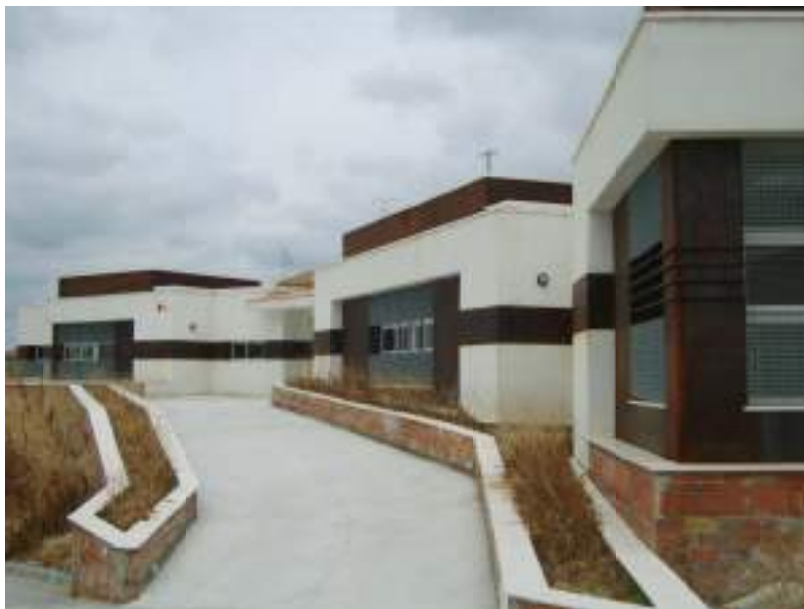
Imagen 27: Nuevo Centro de Salud de Montemayor
